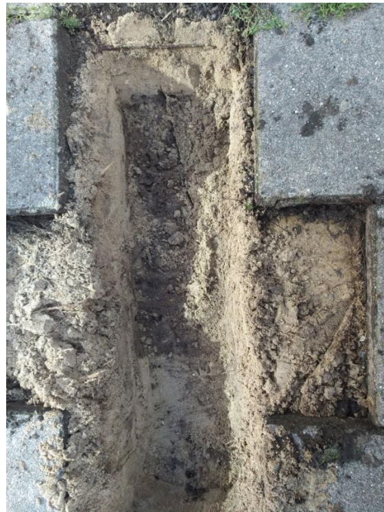
Tot 1,5 m uit de boom is bomenzand ingevuld (bovenste helft van de sleuf).
