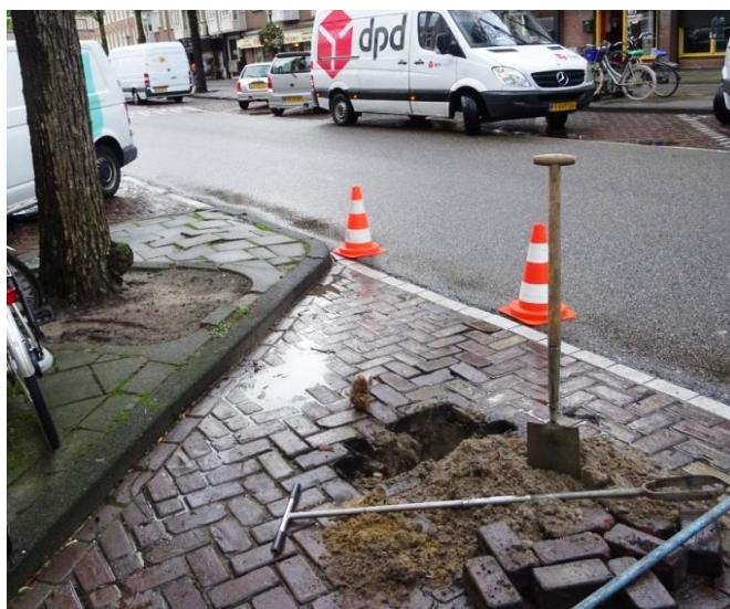
In de kuil bij boom 47 is oude verharding aangetroffen.
